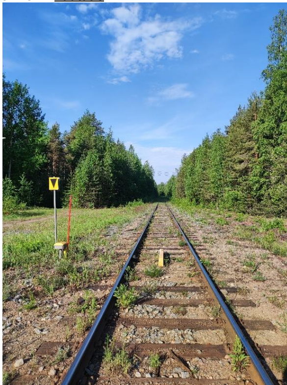
Kuva 9.1. Jyrängön pohjavesialueella kulkevaa rataosuutta.
