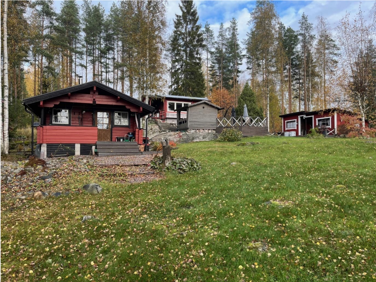
Kuva 1: Määräalan 4:103 rakennukset 1-3 (etelästä)
