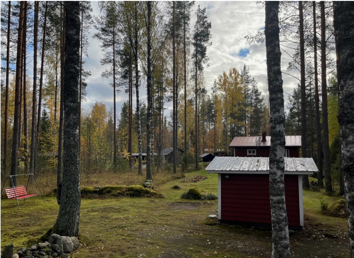
Kuva 2: Määräalan 4:100 rakennukset 4-6 (pohjoisesta)
