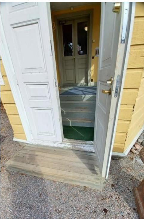
Ulko-ovea ja sen yläpuolista ikkunaa pudotettiin niin, että sisäänkäynti saatiin esteettömäksi. Kuistin lämmöneristystä parannettiin ja teetettiin uudet väliovet.
