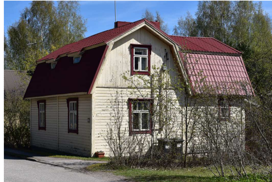
Kuva: Jyrängökatu. Mansardi- eli taitekatto oli suosittu 1920-luvun alkuun saakka, koska katto mahdollisti pieneenkin taloon tilavien lisähuoneiden teon ullakkokerrokseen. Harjakatto vakiinnutti asemaansa 1920-luvulta lähtien. Se sopi perinteiseen, yksikertaiseen rakennustapaan ja omakotitalomalliin, johon pientalorakentamista ohjattiin valtion harjoittamalla tukipolitiikalla ja asuntonormien määrittelyllä sekä tyyppiirustusten kehittälyllä.
