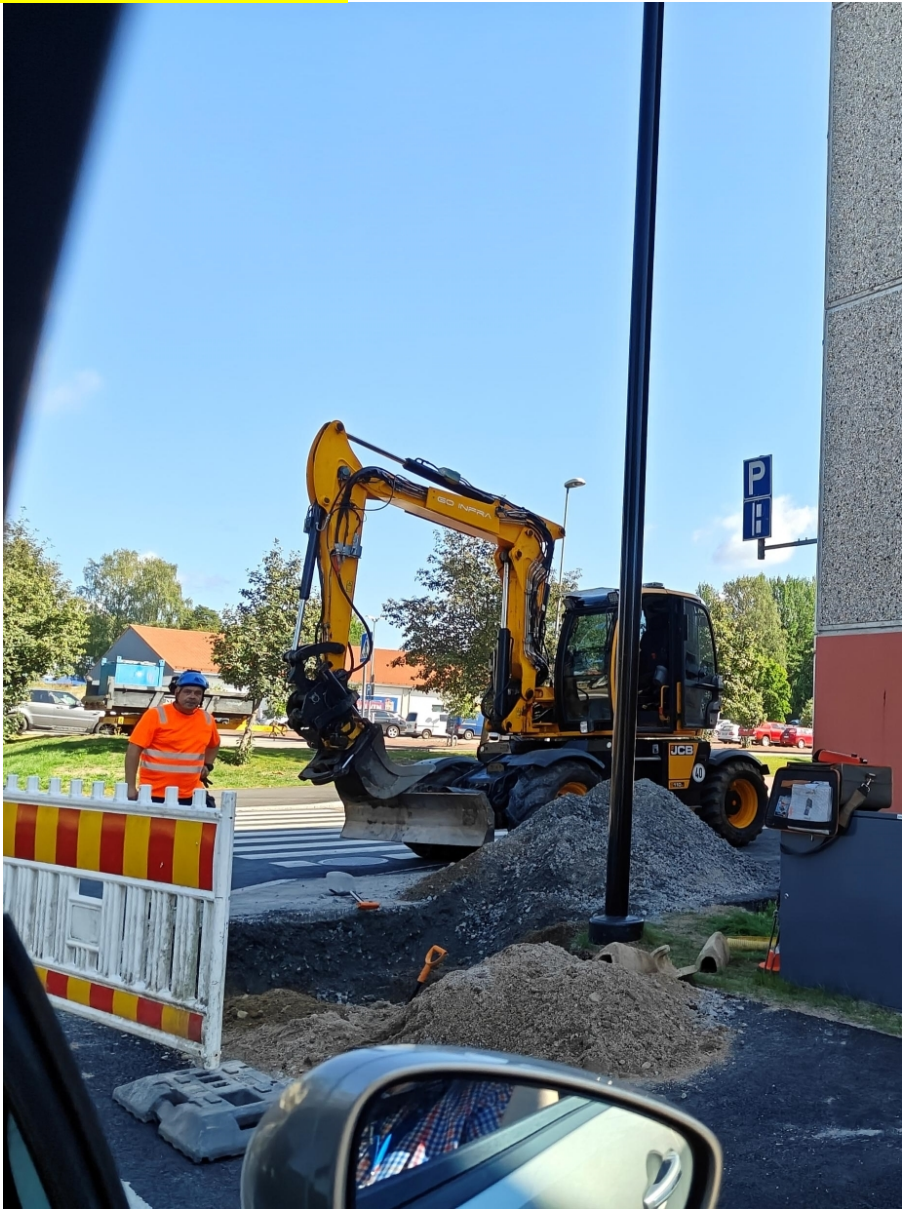
Sähkövikatyömaa 11.8.2025 Hetki avattu uudet pinnat!
