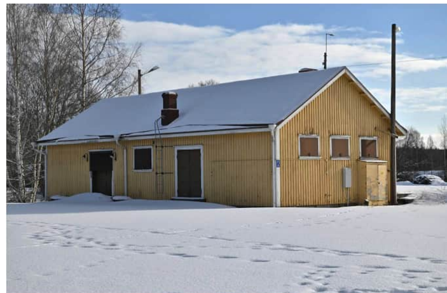
Kuva: Makasiinin toimistotilojen puolella on ollut puulämmitys. Ikkunapuitteet ovat säilyneet suojalevyjen alla.
