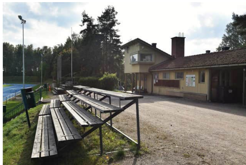
Kuva: Urheilukentän pukusuojarakennus ja yleisurheilukentän katsomo.
