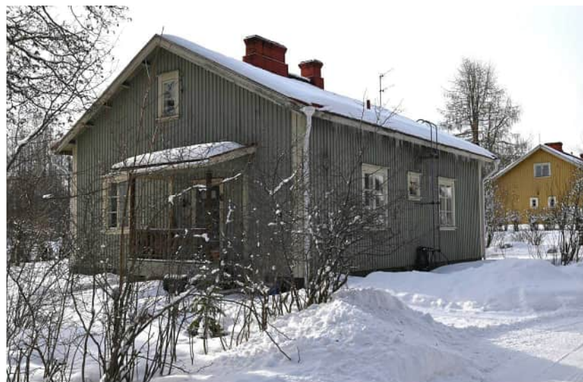
Kuva: Julkisivu raitille päin. Kuistien puukaiteet uusittu. Pystylaudosta jäänyt pois piirustuksen mukainen muotoilu.
