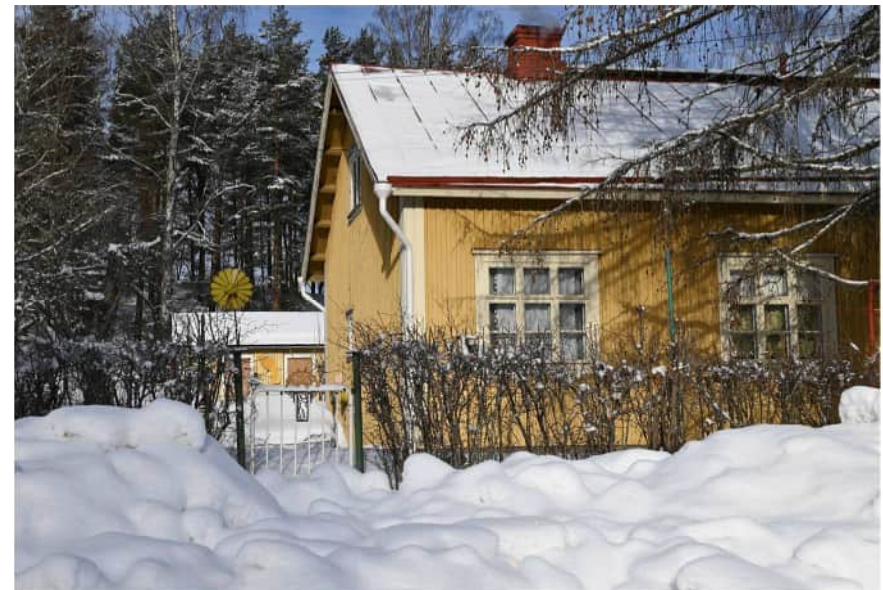
Kuva: Julkisivu radan suuntaan.
