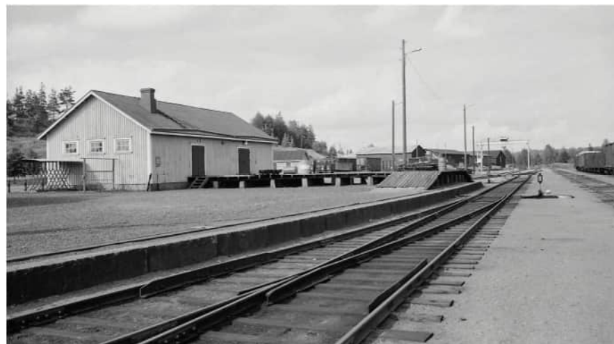
Kuva: Tavaramakasiini ja vanha kivipilareille tehty puinen lastauslaituri. Vaja näkyy taustalla. /Resiina, Vaunut. Tapio Keränen 1971.
