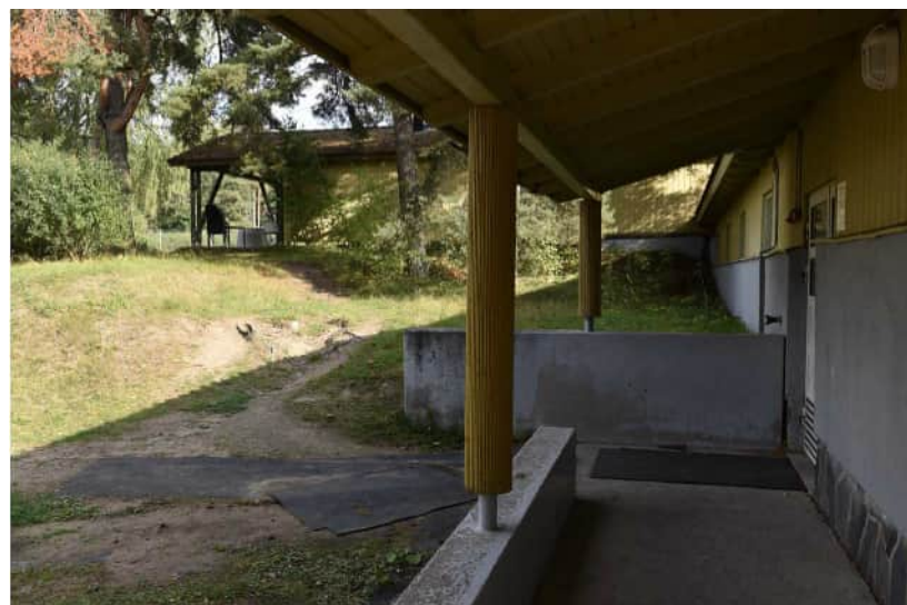
Kuva: Pukusuojasiiiven pohjoisjulkisivun ovelle johtavaa katosta ei ole vuoden 1950 piirustuksissa. Alun perin ovi sijaitsi päädyssä (jossa nyt ikkuna). Ilmakuvista päätellen katos on tehty aikaisintaan 1960-luvulla, mutta yksityiskohdiltaan samanlaisena (pylväät ja katonkannattajien muotokieli).
