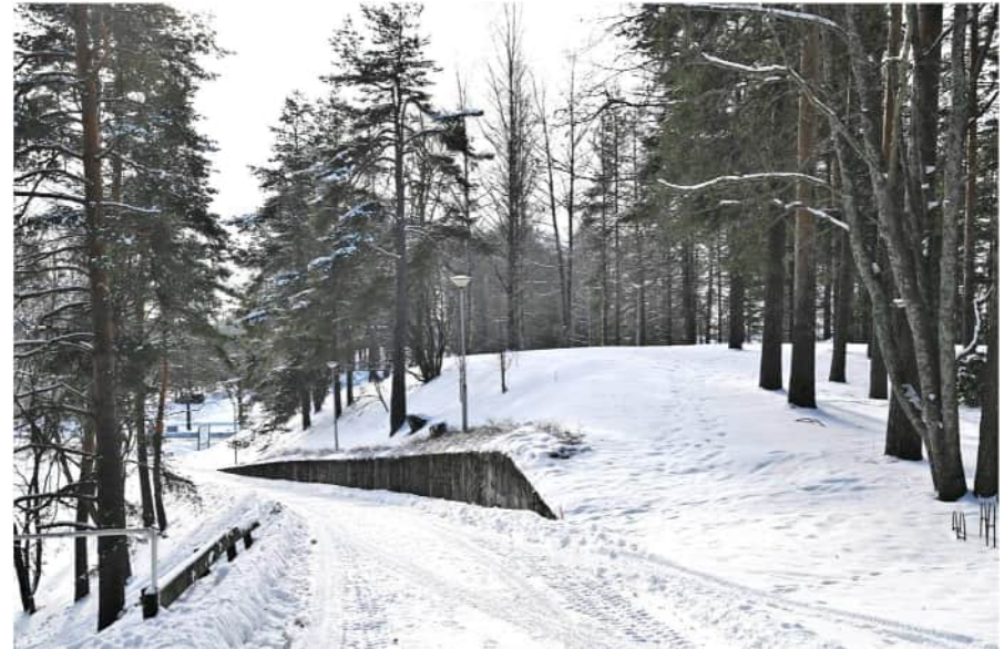
Kuva: Vesitornille nouseva ajoväylä on tuettu liuskekipipintaisella tukimuurilla. Taaempana näkyy harjun poikki leikkaukseen tehty Kauppakatu.
