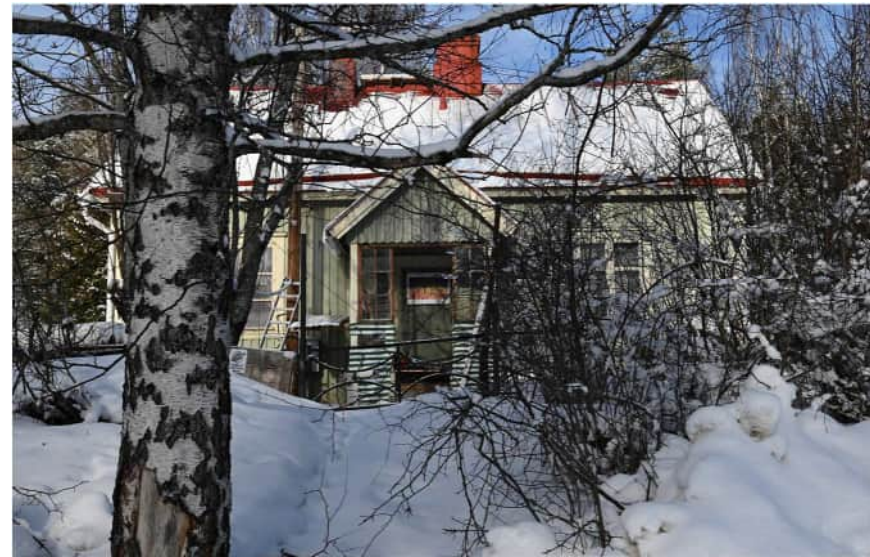
Kuva: Julkisivu radan suuntaan.
