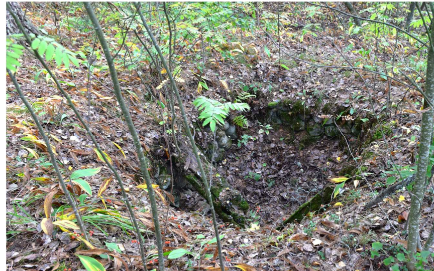
Kuva: Luonnonkiviseinäinen maakuoppa harjurinteessä.
