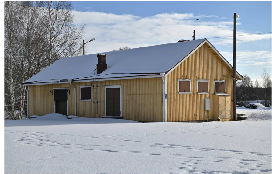
Kuva: Makasiinin toimistotilojen puolella on ollut puulämmitys. Ikkunapuitteet ovat säilyneet suojalevyjen alla.
