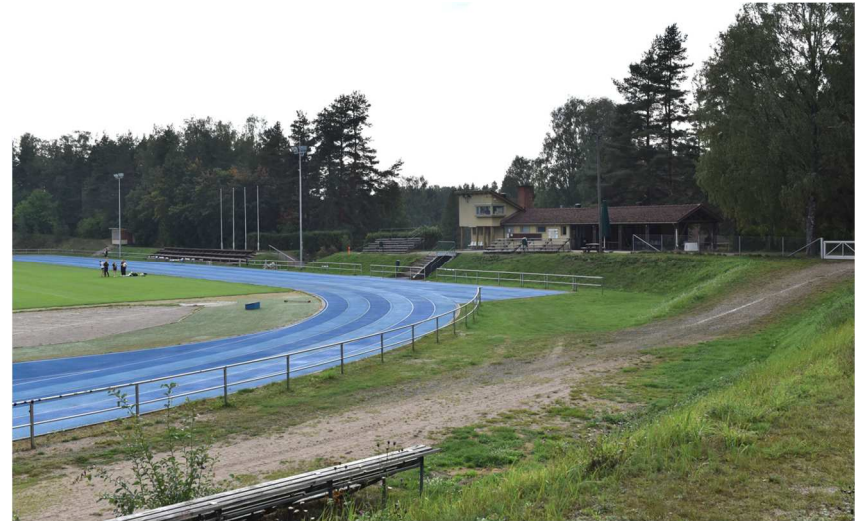
Kuva: Vuonna 1951 valmistunut pukusuojarakennus kuvattuna suppaan perustetun kentän koilliskulmalta. Alakatsomon oikealla puolella on alkuperäisellä paikallaan säilynyt pääportti kentälle. Juoksuradalla on sininen Conipur-päällyste.
