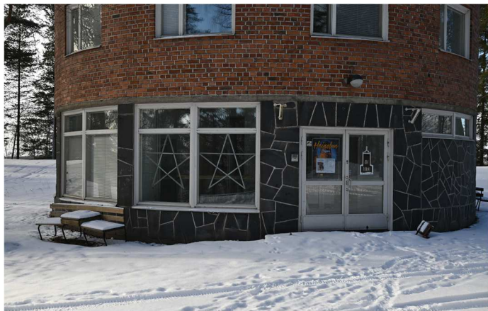
Kuva: Vesitornin sisäänkäynti ja liuske kivillä verhoiltu sokkeli.
