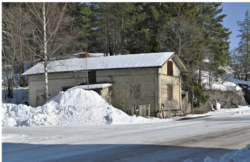
Kuva: Hirsi- ja ehkä osaksi myös lautarunkoinen puutalo on jääne Supin alueelle 1800-luvulla rakentuneesta työläisasutuksesta.
