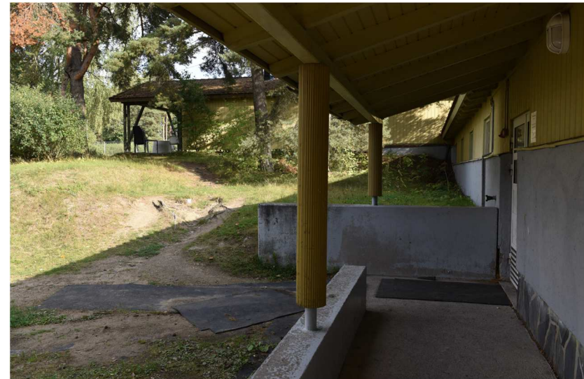
Kuva: Pukusuojasiihen pohjoisjulkisivun ovelle johtavaa katosta ei ole vuoden 1950 piirustuksissa. Alun perin ovi sijaitsi päädyssä (jossa nyt ikkuna). Ilmakuvista päätellen katos on tehty aikaisintaan 1960-luvulla, mutta yksityiskohdiltaan samanlaisena (pylväät ja katonkannattajien muotokieli).
