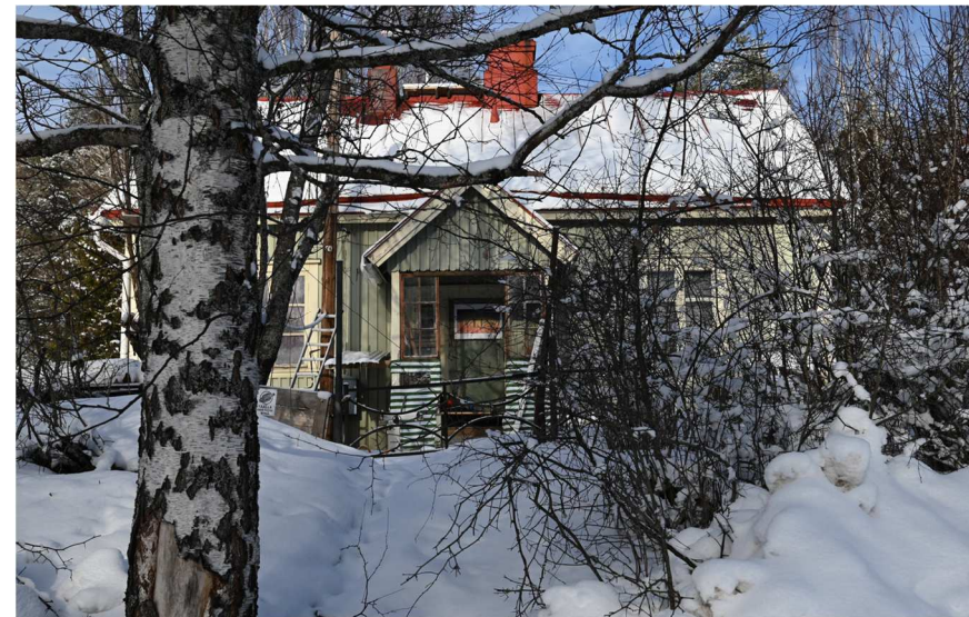
Kuva: Julkisivu radan suuntaan.
