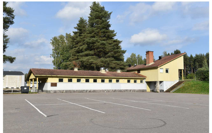
Kuva: Pukusuojat ja peseytymistilat sijaitsevat rakennuksen pitkässä siivessä, joka rajautuu urheilukentän viereiseen asfaltoituun pysäköintialueeseen.
