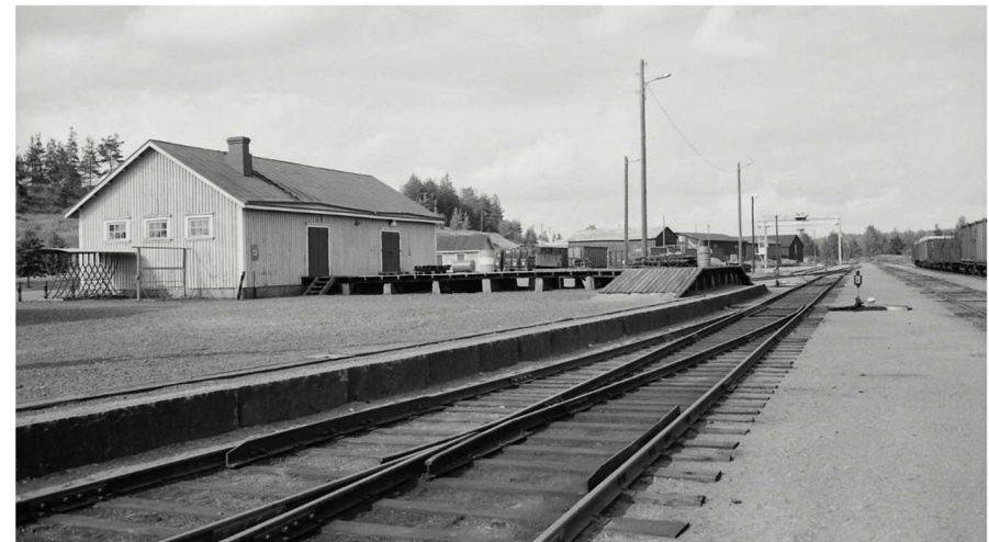
Kuva: Tavaramakasiini ja vanha kivi-pilareille tehty puinen lastauslaituri. Vaja näkyy taustalla. /Resiina, Vaunut. Tapio Keränen 1971.
