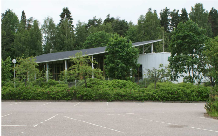
Kuva: Uimahallin eteläjulkisivun kaareva katos (terapia-allasosaston edustalla) on tehty 2000-luvun vaihteessa toteutun remontin yhteydessä. /Valokuva vuodelta 2014 .
