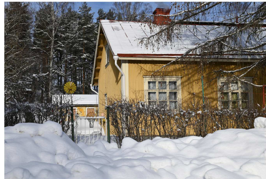
Kuva: Julkisivu radan suuntaan.
