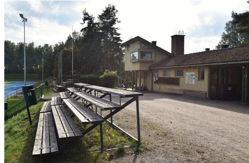
Kuva: Urheilukentän pukusuojarakennus ja yleisurheilukentän katsomo.
