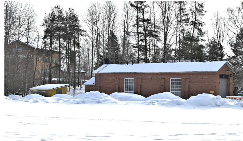
Kuva: Suunnittelualueen ulkopuolelle jää ratapihan itäpuolella sijaitseva yksipilttuinen veturitalli vuodelta 1931. Rakennus on muurattu tiilestä. Rakennuksesta on 2010–11 uusittu päädyn ovi (nosto-ovena), ikkunat (karmijako vaihdettu, rimoitus alkuperäisen kaltainen) ja vesikatto (profiilipelti, edellinen huopaa; savutorvet poistettu). / Moottorivaunuvaja, arkkitehti Jarl Ungernin piirustus nro 1853, pohja, 2 leikkaus, 3 julkisivu. Muutostöimenpiteitä oli tehty mm. 1942.
