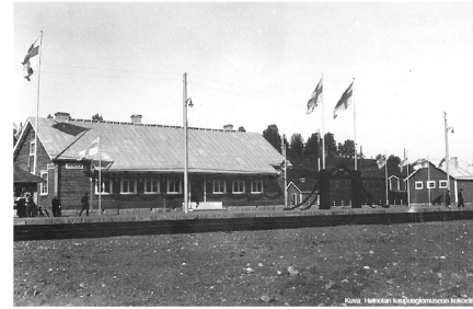
Kuva: Vastavalmistunut asemarakennus on vielä hirsipinnalla. Taaempänä näkyy tavaramakasiini ennen 1933 tehtyä laajennusta. / Heinolan kaupunginmuseon kokoelma.
