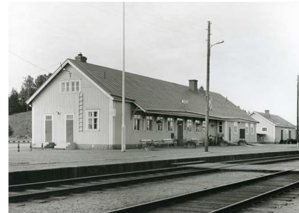
Kuva: Asemarakennusta on jatkettu 1950-luvun lopussa makasiinin puoleisesta päädyistä. Heinolan rautatieasema tuhoutui tulipalossa 1988. / Kuvaaja Olavi Karasjoki 1966. Suomen Rautatiemuseo. Finna.fi
