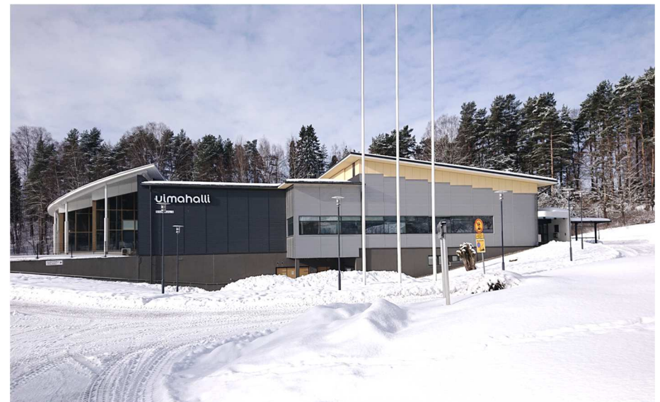
Kuva: Julkisivu itään. Viimeisimmän peruskorjaussuunnitelman laati Arkkitehtitoimisto Minkkinen Oy 2014, remontti valmistui 2016 . Tässä yhteydessä uudistettiin julkisivuja ja rakennusta myös laajennettiin / korotettiin. Rakennuksen julkisivuissa on käytetty pääasiassa teräsaaltolevyä (Ruukki Oy) ja kuitusementtilevyä (Cembrit). Sokkeli on betonia ja vesikate bitumihuopaa.
