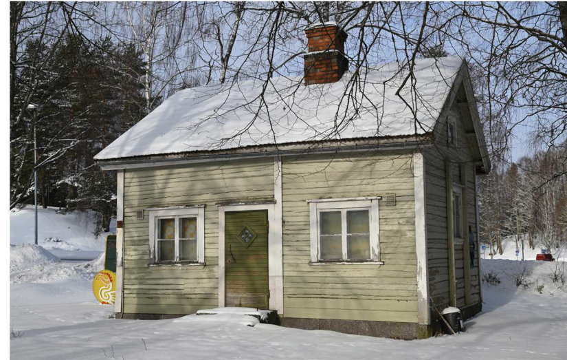
Kuva: Rautatieläisten asuinalueen saunarakennus on asemapuiston puolella. Yhden seinän osalta pari alinta hirsikertaa vaihdettu, myös listoja paikkokorjattu. Päätykolmioiden ikkunoissa ei ole enää välipystypienaa.
