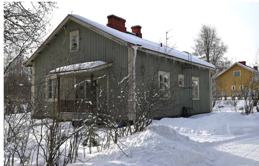
Kuva: Julkisivu raitille päin. Kuistien puukaiteet uusittu. Pystylaudosta jäänyt pois piirustuksen mukainen muotoilu.
