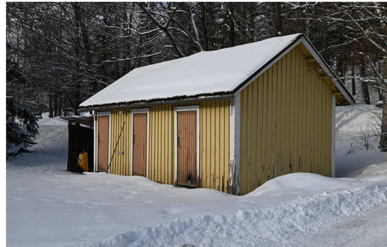
Kuva: Samaa alun perin 1920-luvulla suunniteltua halkovajan tyyppiirustusta soveltaen rakennettiin kaikki Heinolan aseman halkosuojat. Kuvassa näkyvä halkovaja on tehty 40-luvun puolivälin paikkeilla tuolloin rakennetun asuinrakennuksen yhteyteen. Sen seinien laudoitustapa, ovipaneelin suunta ja sokkelimateriaali ovat erilaiset kuin vanhemmassa 30-luvun halkovajassa.
