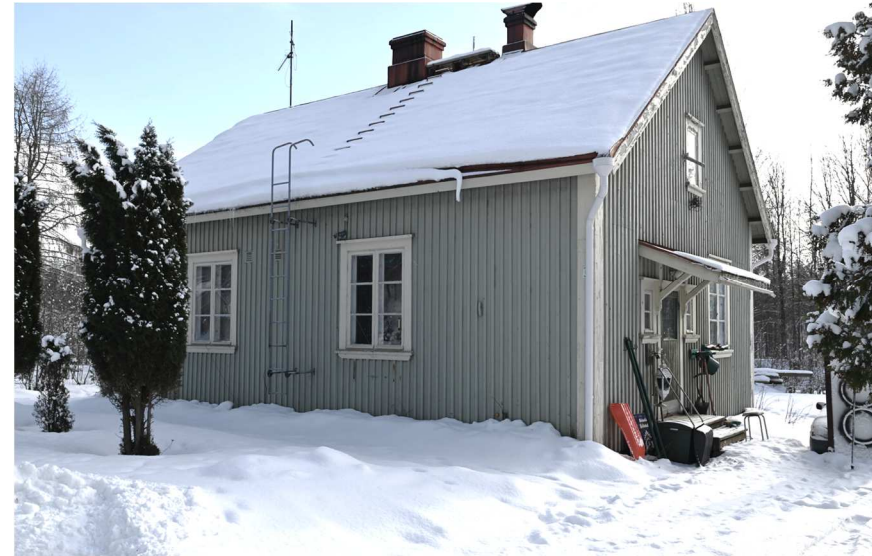
Kuva: Julkisivu raitille päin. Kaikissa taloissa on vanhat sisään–ulos-aukeavat ikkunat, joissa suorat vuorilaudat, lippalauta ja vesilaudan alapuolella viistoreunainen koristelista.
