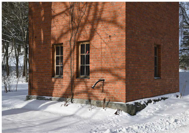
Kuva: Lohkokivijalka. Kapeat ikkunat.
