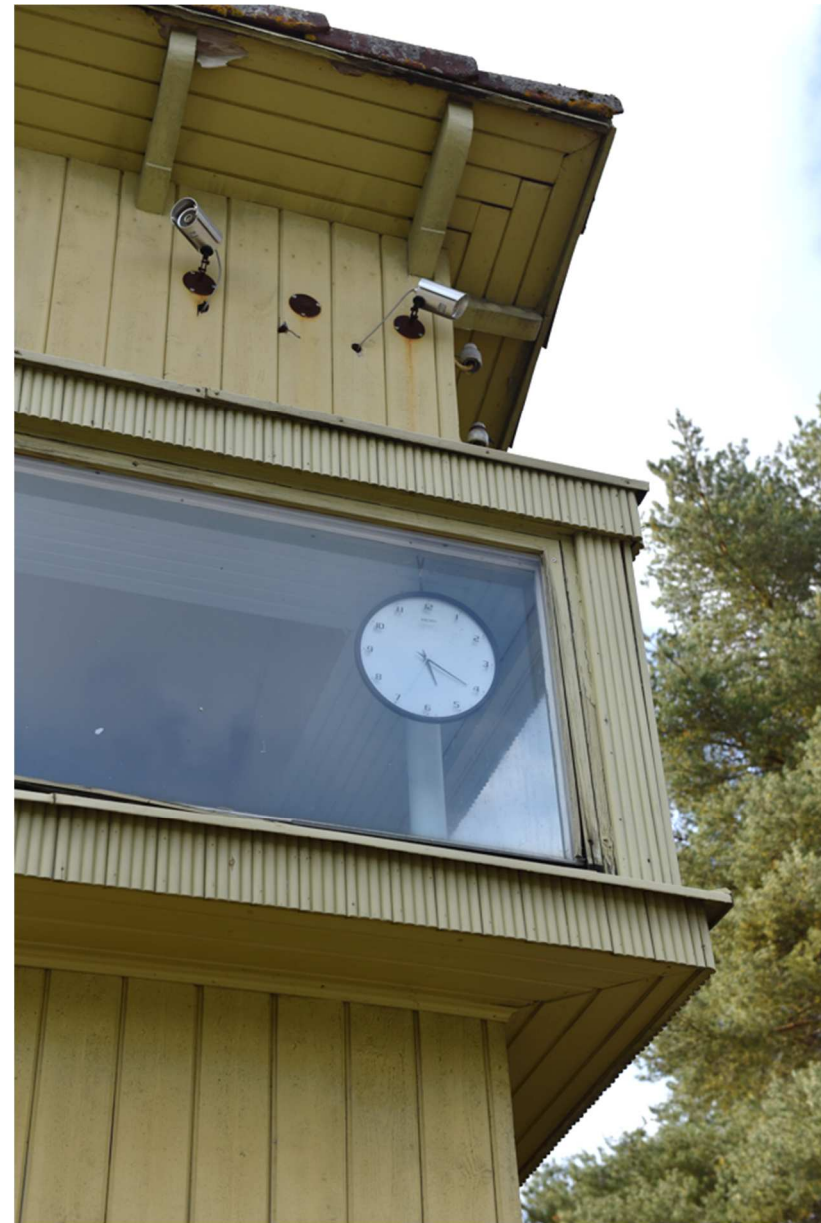
Kuva: Pukusuojarakennuksen kuuluttamon kulmaikkuna.
