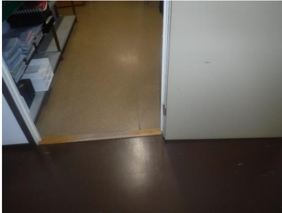
Yleiskuva, vinyylilaatta- ja muovimattopintainen välipohja
