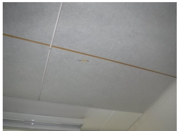
Akustiikkalevyissä on avoimia mineraalivillapintoja
