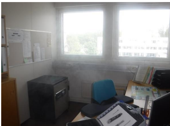
Savukokeiden perusteella tuloilma levisi tasaisesti huonetiloihin
