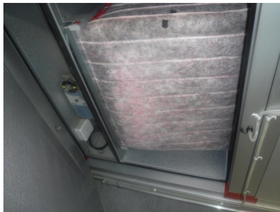
Ilmanvaihtokoneiden kammiot olivat puhtaita
