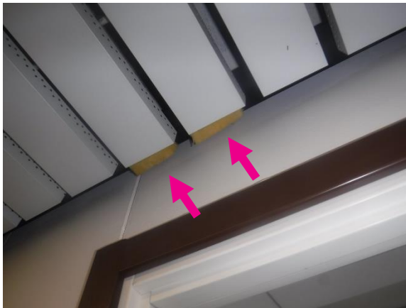
Alakattotiloissa on avoimia mineraalivillapintoja
