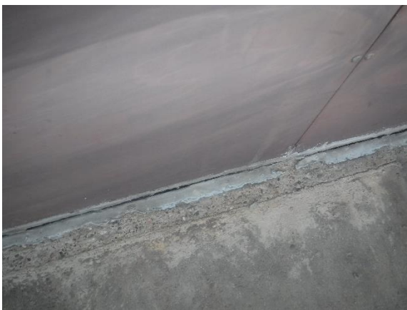
Pellityksen kittaus rakoilee
