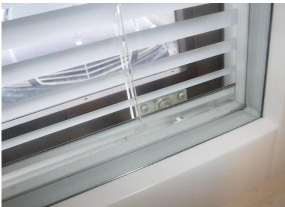
Ikkunat ovat uusitut, käynti- ja tiivistyspuutteita ei havaittu
