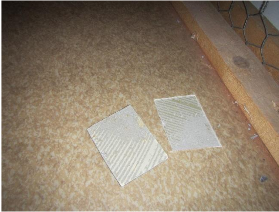
Muovimattojen liimapinnoilla havaittiin vähäisiä värimuutoksia
