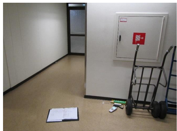
Yleiskuva, muovimattopintainen alapohja
