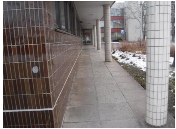
Yleiskuva, laattapintainen julkisivu
