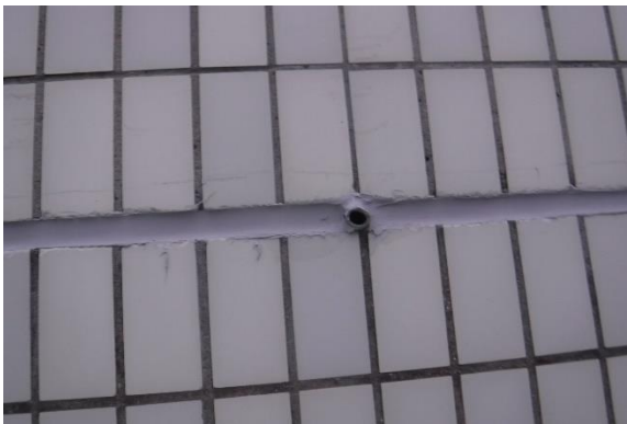
Elastiset saumat on uusittu ja hyväkuntoiset
