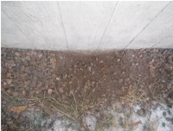
Sokkelin ulkopuolista veden- tai lämmöneristystä ei havaittu koekuopan perusteella
