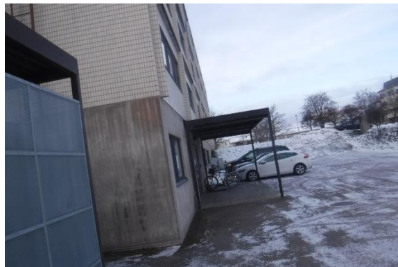
Sisäänkäyntikatoksen vedenpoisto on räystältä valuen
