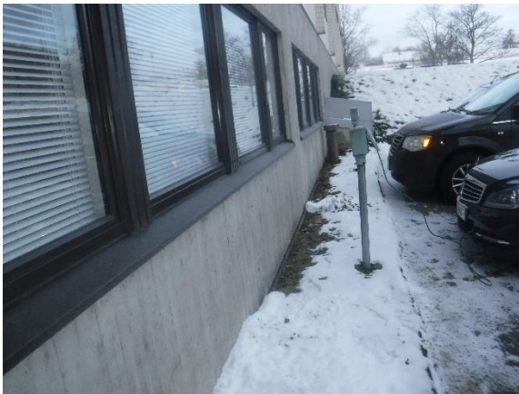
Yleiskuva, pinnoittamaton betonipintainen julkisivu
