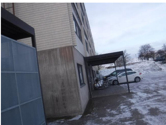
Leväkasvustoa betonipinnassa
