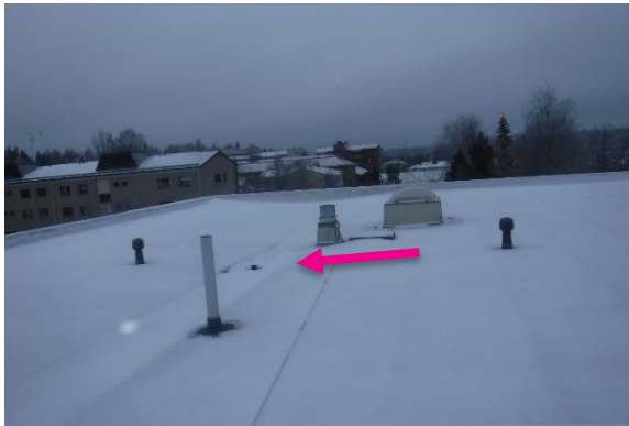
Vesikatolla on hyvät kallistukset kohti kattokai-voja
