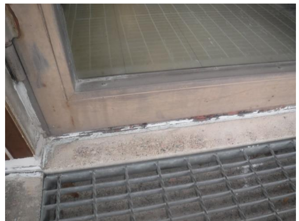
Korroosioaurioita kynnyksellissä
