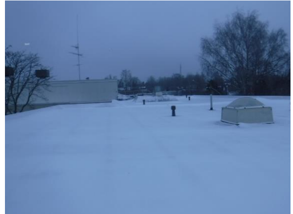
Yleiskuva IV-konehuoneen vesikatolta
