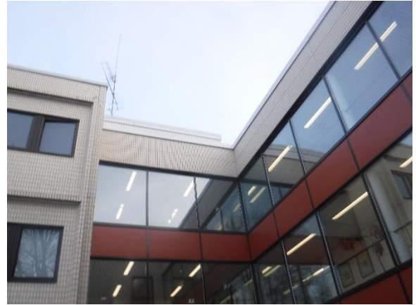
Yleiskuva, lasijulkisivuseinästä, joka on uusittu vuonna 2017
