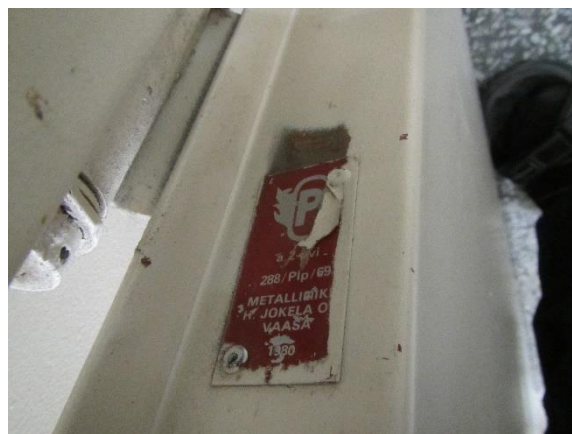
Vanhat palo-ovet saattavat sisältää asbestia
