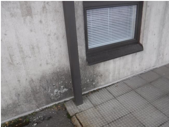
Värjäytymiä betonipinnassa
