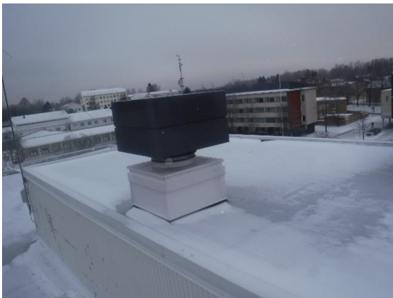
Yleiskuva IV-konehuoneen vesikatolle
