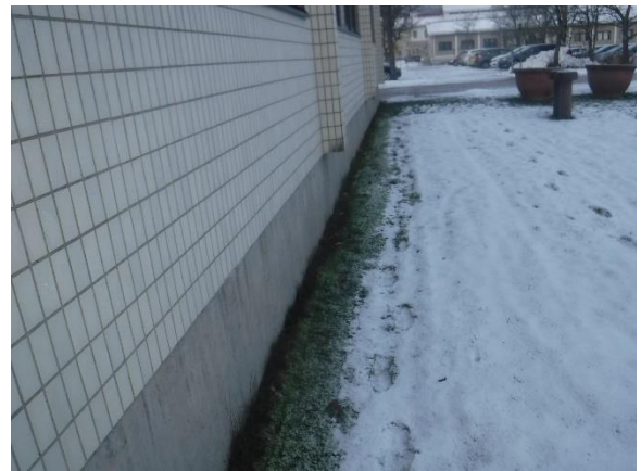
Yleiskuva, pinnoittamaton betonisokkeli
