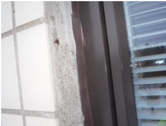
Raudoitus pinnassa ikkunan pielessä.
