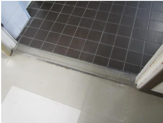
Vanhojen muovisten kynnykslistojen lyijypitoisuus on yleisesti korkea
