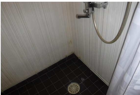
Märkätilat ovat pinnoiltaan alkuperäiset ja käyttökänsä päässä
