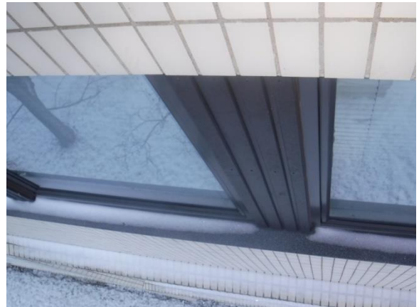
Ikkunat ovat uusitut ja hyväkuntoiset
