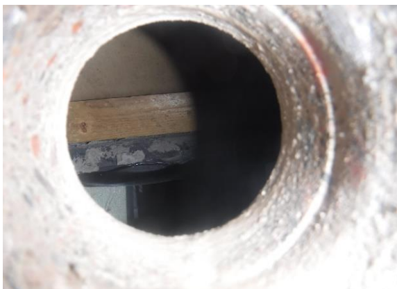
Yläpohjassa on reilu tuulettuva ilmatila
