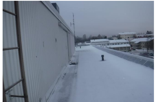
Vesikatolla ei havaittu jäätyneitä veden lammi-koitumista
