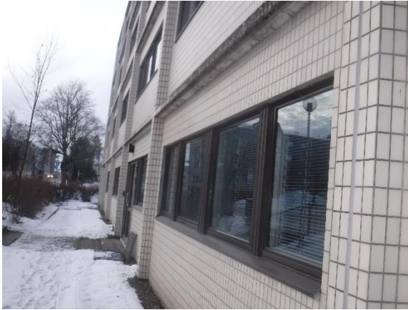
Yleiskuva, laattapintainen julkisivu
