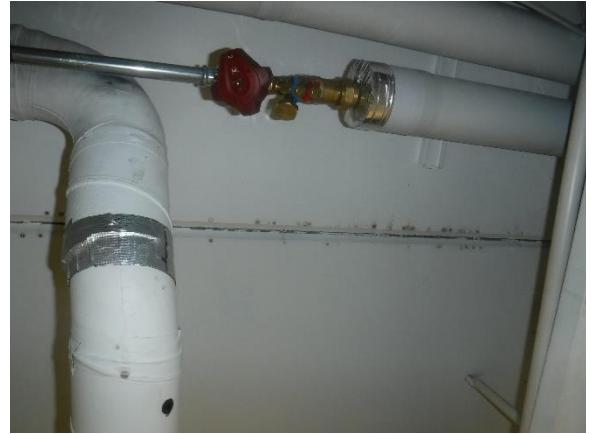
Välipohja rakoilua ja kuivuneita vesivuodon jälkiä
