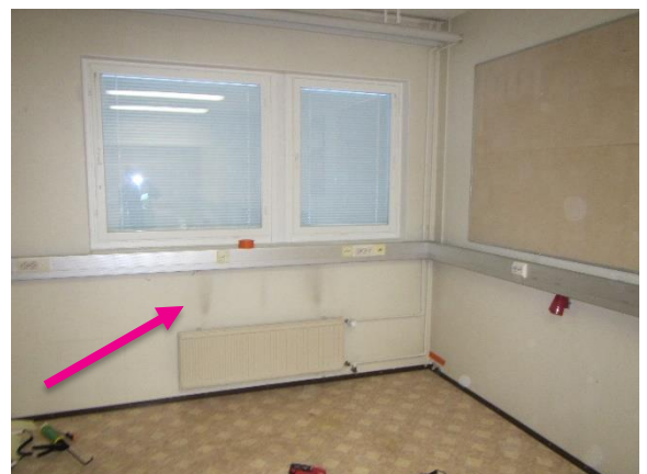
Näkyviä merkkejä ilmapuotoja patterien kiinnikkeistä
