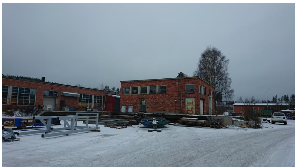
Kuva 14. Asemakaavamuutoksen teollisuus- ja varastorakennusten alueella sijaitseva vuonna 1953 kaasulaitokseksi rakennettu rakennus (Kuva 7 nro 7)
