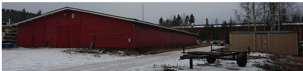
Kuva 12. Asemakaavamuutoksen teollisuus- ja varastorakennusten alueella sijaitseva vuonna 1965 rakennettu rakennus (alkuperäinen käyttötarkoitus radiaattorivarasto) (Kuva 7 nro 5) ja pienempi muuntamorakennus
