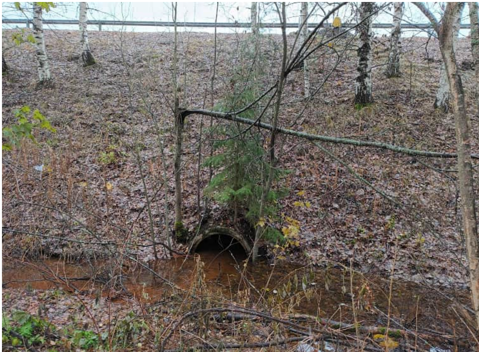
Kuva 12. Sukurantien alittava 1000 mm betonirumpu ja hulevesien purkupiste etelään. [Ramboll 9.11.2023]
