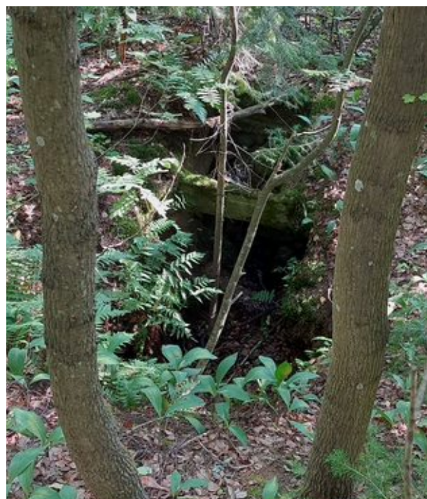
Betonista osin rakennettu kellari (no. 9). Kuva Oskari Sairanen, Maanala Oy.
