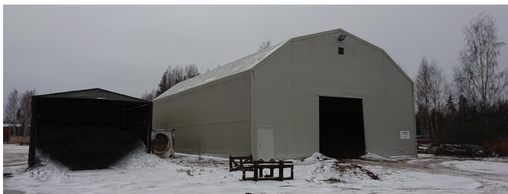
Kuva 10. Asemakaavamuutoksen teollisuus- ja varastorakennusten alueella sijaitseva 2011-12 rakennettu rakennus (suolavarasto) (Kuva 7 nro 3)
