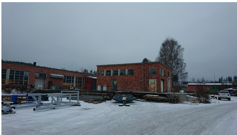
Kuva 14. Asemakaavamuutoksen teollisuus- ja varastorakennusten alueella sijaitseva vuonna 1953 kaasulaitokseksi rakennettu rakennus (Kuva 7 nro 7)
