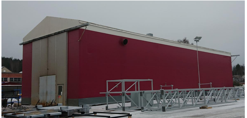
Kuva 15. Asemakaavamuutoksen teollisuus- ja varastorakennusten alueella sijaitseva vuonna 2004 rakennettu viimeistelyhalli, maalaamo (Kuva 7 nro 8) Kuvissa 8.-15. esitettyjen rakennusten rakentamisajankohdat ja käyttötarkoitukset perustuvat kaavaa varten laadittuun rakennusinventointiin (FM Teija Ahola, Selvitystyö Ahola 25.9.2023).
