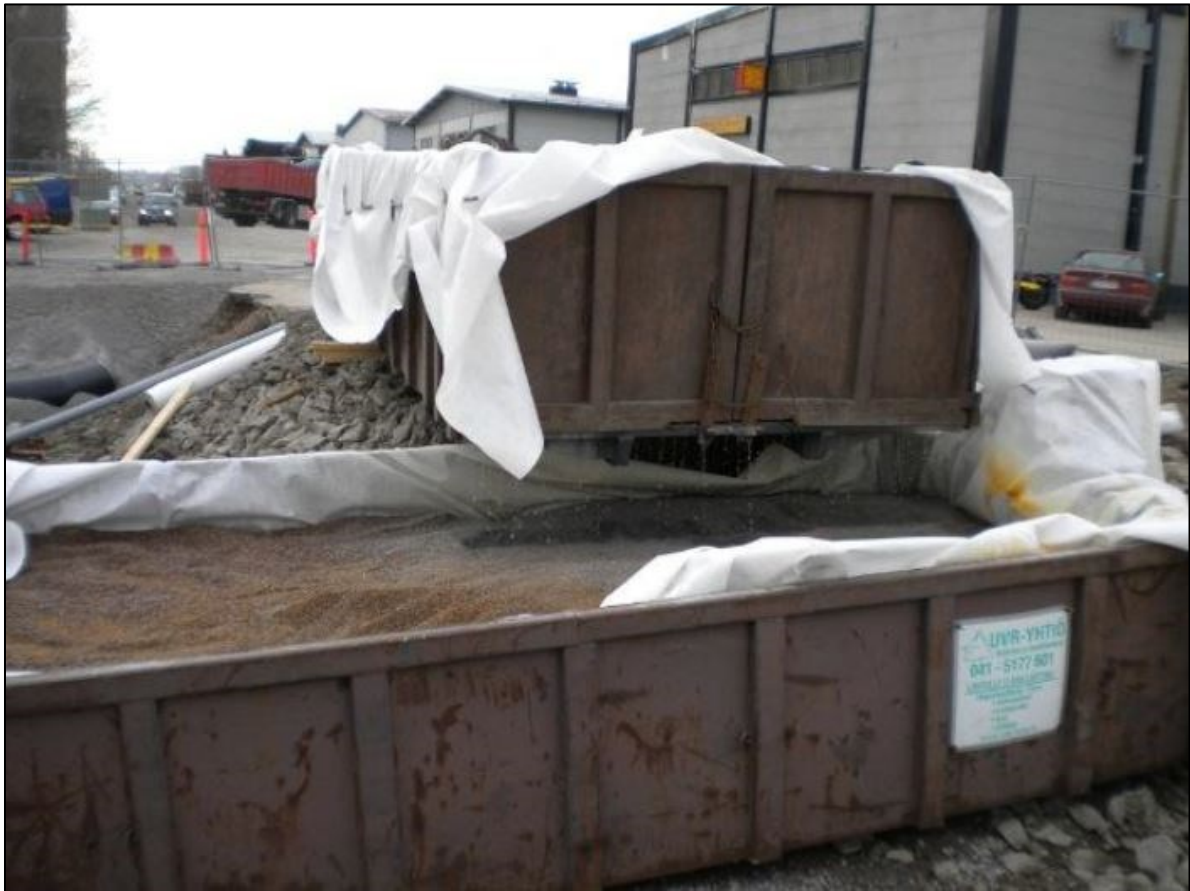
Kuva 13. Esimerkkikuva vaihtolavan sisään rakennetusta suodattimesta. 4
