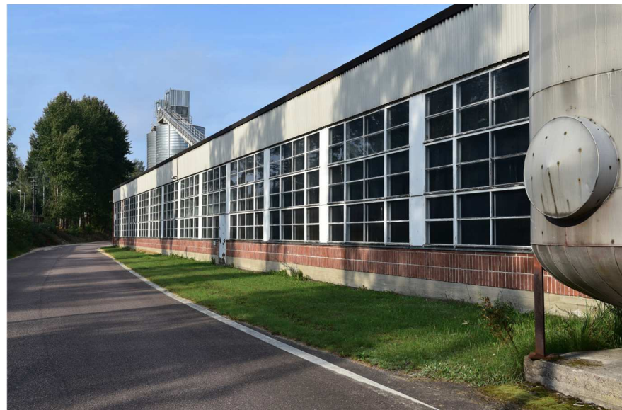
Kuva: Tehtaan viimeisen laajennuksen julkisivuissa on enemmän Minerit-levyä kuin punatiiltä. Ikkunat tehtiin vanhan mallin mukaan. Räystäspeltti on kuparia.
