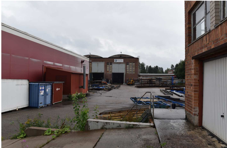
Kuva: Nro 11 maalaamo (1022159955, 2004), taustalla kattilahitsaamo.
