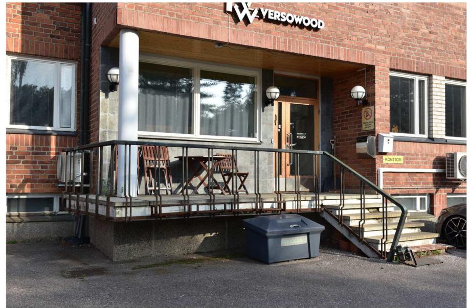
Kuva: Vuonna 1957 rakennetun kaksikerroksisen konttorisiiven pääsisäänkäynnin yhteydessä on säilynyt alkuperäisiä elementtejä, kuten pylväs, metallikaide ja kivilaatat.
