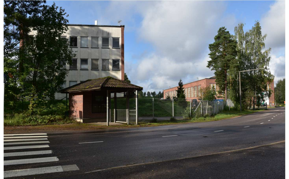
Kuva: Tähtiniementien porttirakennus ja metalliverkkoaitaa. Ajoportti on edempänä vanhan kattilatehtaan kohdalla.
