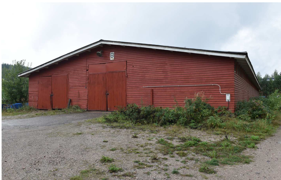
Kuva: Nro 8 Radioattorivarasto (1022159933, RL 1962). Ulkoseinissä on viistopintainen vaakalaudoitus jiirinurkin.
