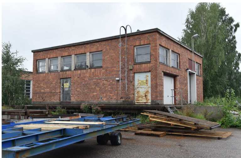
Kuva: Nro 4 Kaasunkehityslaitoksessa (ei tunnusta, Tor-Eric Herler 1952) oli oma huone hapen jakelulle, happipulloille ja karbidille sekä iso huone asetyleenin kehitykselle. Tiilirakennuksessa on loiva pulpettikatto ja tasapäädyt. Ikkunapilarit ovat kahi-tiiltä, kuten muissakin tiilirakennuksissa. Myöhemmin tehty muutoksia luoteisjulkisivun oviaukkoihin.
