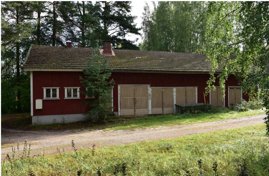
Kuva: Kymi-yhtiön puurakenteinen rakennus Tähtiniementien itäpuolella.
