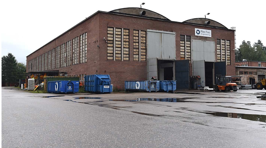
Kuva: Entisen kattilahitsaamon pääty on noin 33 metriä leveä. Suuret oviaukot on tehty jälkeen päin. Alkuperäinen hallinovi oli kuvassa näkyvistä vasemmanpuoleisen oven kohdalla, mutta sen yläreuna ylsi niukasti toisen ikkunaruudun tasolle.
