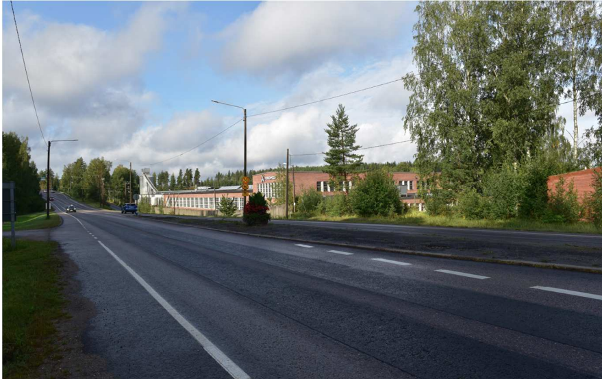
Kuva: Suoraa Lahdentietä tehtaan eteläpuolella. Näkymän päässä tie nousee mäelle, jossa sen kanssa risteää Hevossaarentie (eritasoliittymän silta). Jo ennen moottoritien rakentamista Lahdentielle oli rakennettu silta Hevossaareen vievän radan yli.
