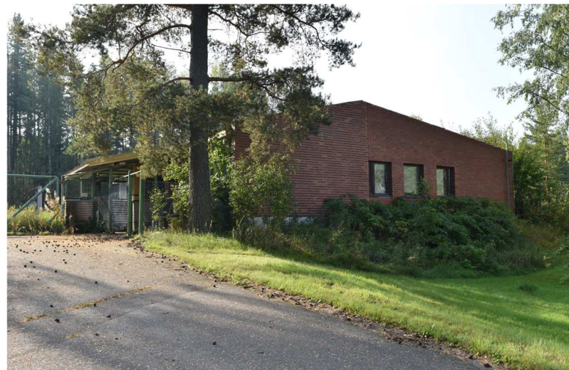
Kuva: Nro 5 Portinvartijan rakennus (1022159999) toimi viimeksi tehtaan terveysasemana, nykyään tyhjiällä (varasto). Laajennusosan (1975) ja vanhan puolen yhtymäkohta erottuu tiilimuurauksessa. Portti jäi käytöstä 1980-luvulla.
