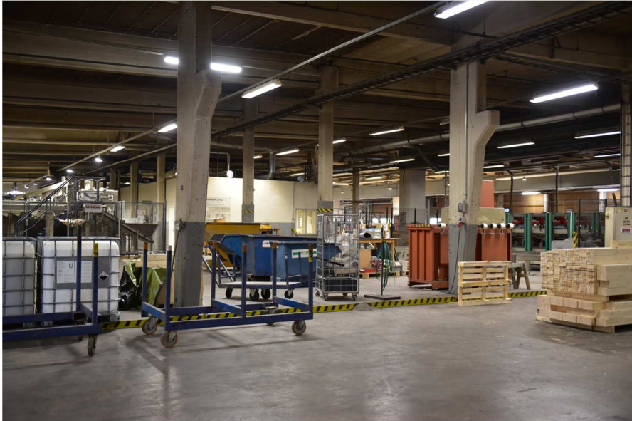
Kuva: Tehtaan eri-ikäiset osat muodostavat suuren hallitilan, jota rytmittävät betonipalkkeja kannattelevat betonipilarit. Hallitiloihin ei avaudu kattoikkunoita. Viimeisen käyttötarkoituksen yhteydessä on purettu muutamia pilareita.
