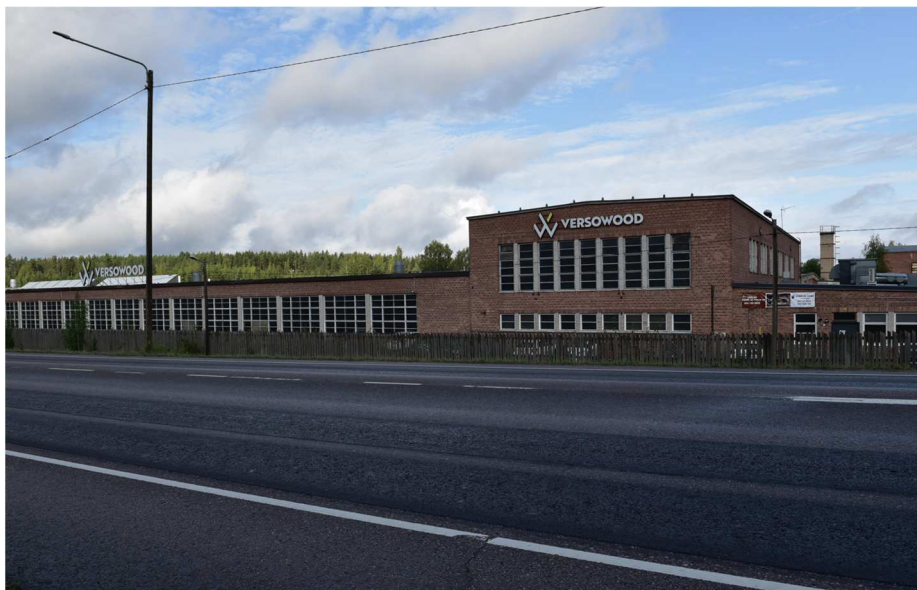
Kuva: Tehdasrakennuksen korkea pääty ja pitkä julkisivu Lahdentien suuntaan. Korkeimman osan huonekorkeus on lähes 10 m. Julkisivumuuraus on tehty ristilimityksenä. Pulpettikattoisen siiven pyöröikkuna on korvattu suorakaideikkunalla.
