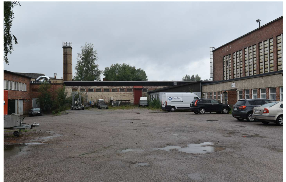
Kuva: Radiaattoritehtaan ja kattilahitsaamon välinen matala yhdyskäytävä.
