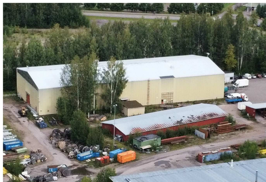
Kuva: Nro 9 tehdasrakennuksessa (1022159911, RL 1975) on peltikatto, profiloitu muovipintainen? teräslevy (alkuperäinen punainen väri kauhtunut pois), betonisokkeli ja teräskarmi-ikkunat. Vesikattoa kannattelevat teräsristikot.
