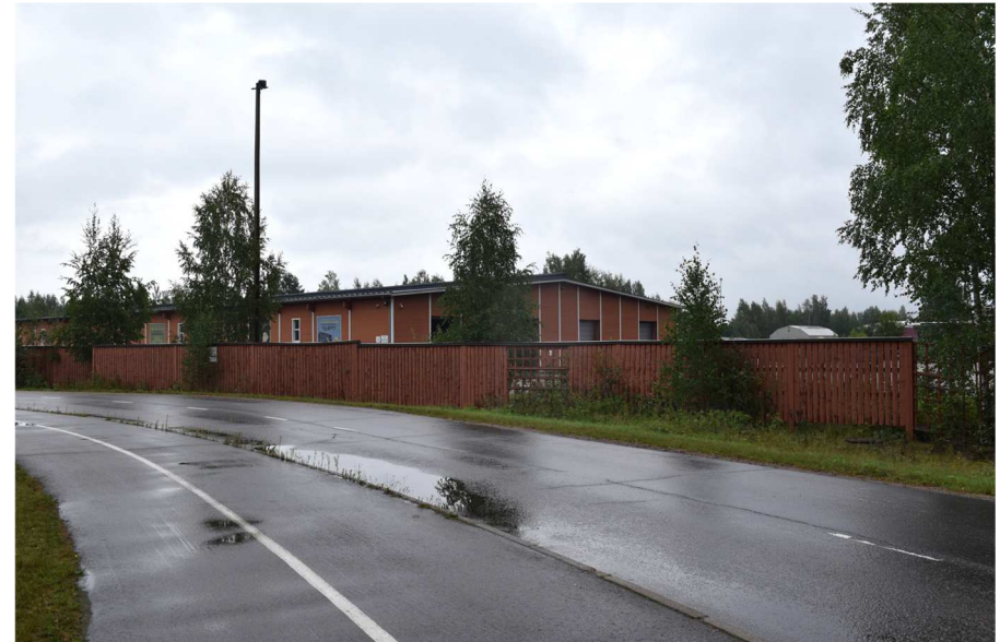
Kuva: Versowoodin teollisuusvarasto (102216000A). Kuvassa näkyvää puuaitaa on tehdasalueen kaikilla sivuilla paitsi Lahdentien puoleisella, jossa yhtenäistä pystylauta-aitaa on maalaamattomana. Paikoin, metsäisillä alueilla, on metalliverkkoaitaa.
