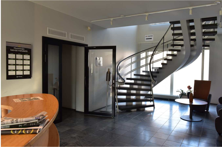
Kuva: Konttorin sisäänkäynti on korkeamman osan kulmalla. Sisätilat on peruskorjattu 1950-luvun tyyliä mukaillen. Alkuperäisinä säilyneisiin rakennusosiin kuuluu sisääntuloaulasta toiseen kerrokseen nouseva kiertoporras ja sen kaide.
