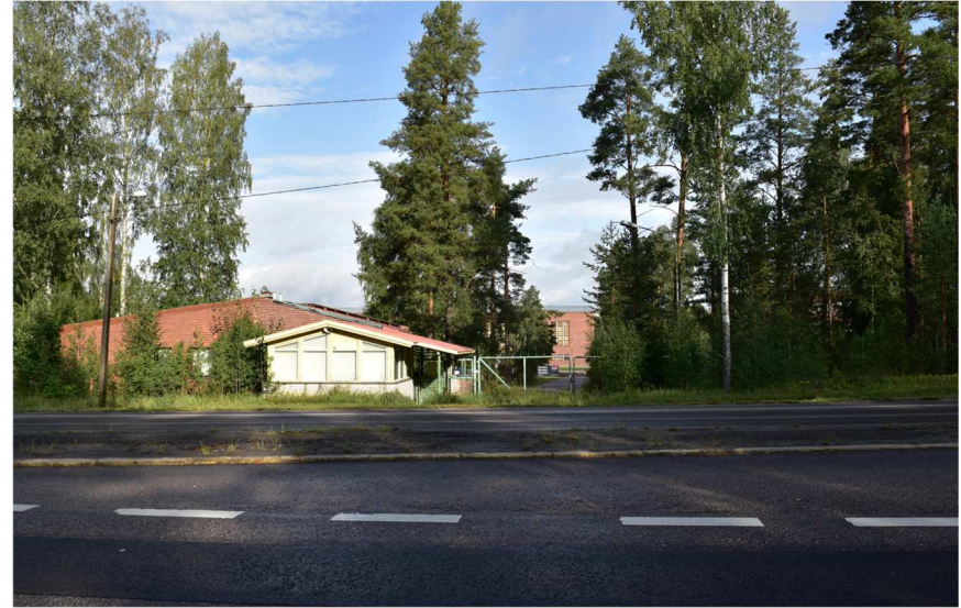
Kuva: Entinen pääportti tehdasalueelle. Kuvassa portin oikealla puolella sijaitsivat pyöräkatokset ja vasemmalla on säilynyt entinen portinvartijan rakennus (T-E. Herler 1957). Sen ja tehtaan välissä oli pieni autopysäköintialue. Taustalla näkyy kattilatehdas.
