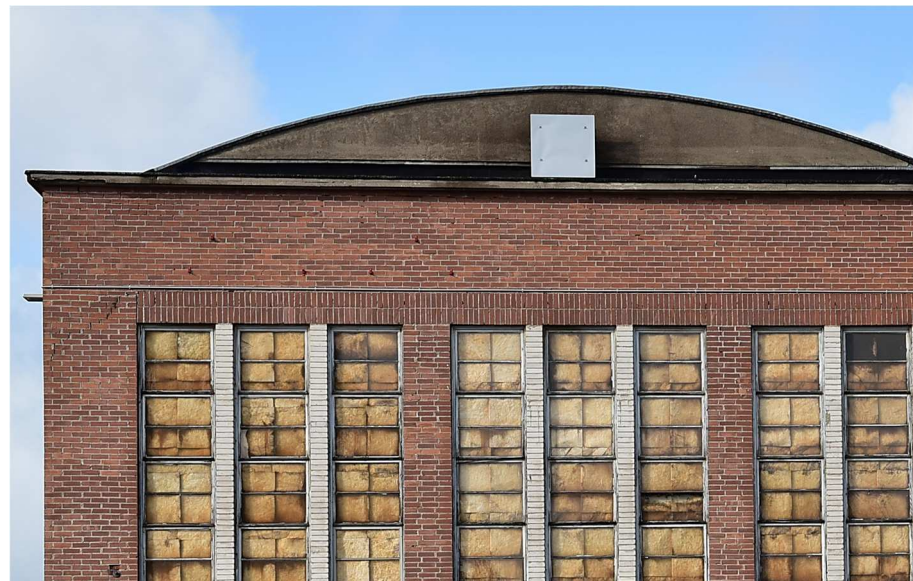
Kuva: Rakennuksen punatiiliseinä ja juoksulimityksellä, seinissä ½ kiven ja ikkunoiden väleissä ¼ k siirtymällä. Ikkunapilarit ovat kahi-tiiltä. Ikkunapuitteet ovat vanhat.
