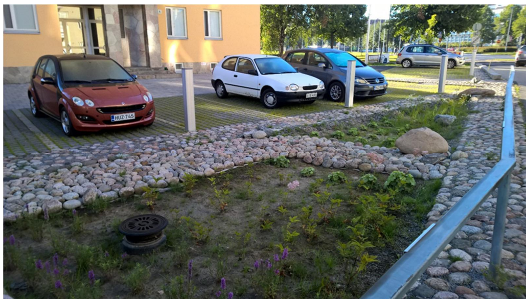
Kuva 3-3. Läpäisevä päällyste ja biosuodatus parkkipaikalla.
