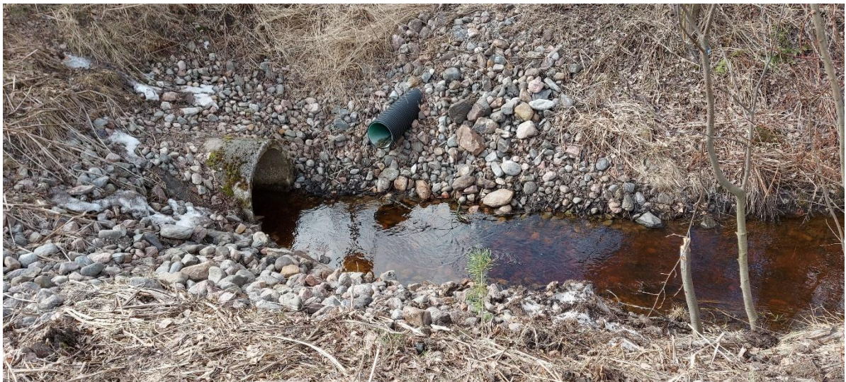
Kuva 6-3. Kaakonlammen purkuoja ja Metsolantien alittava rumpu
