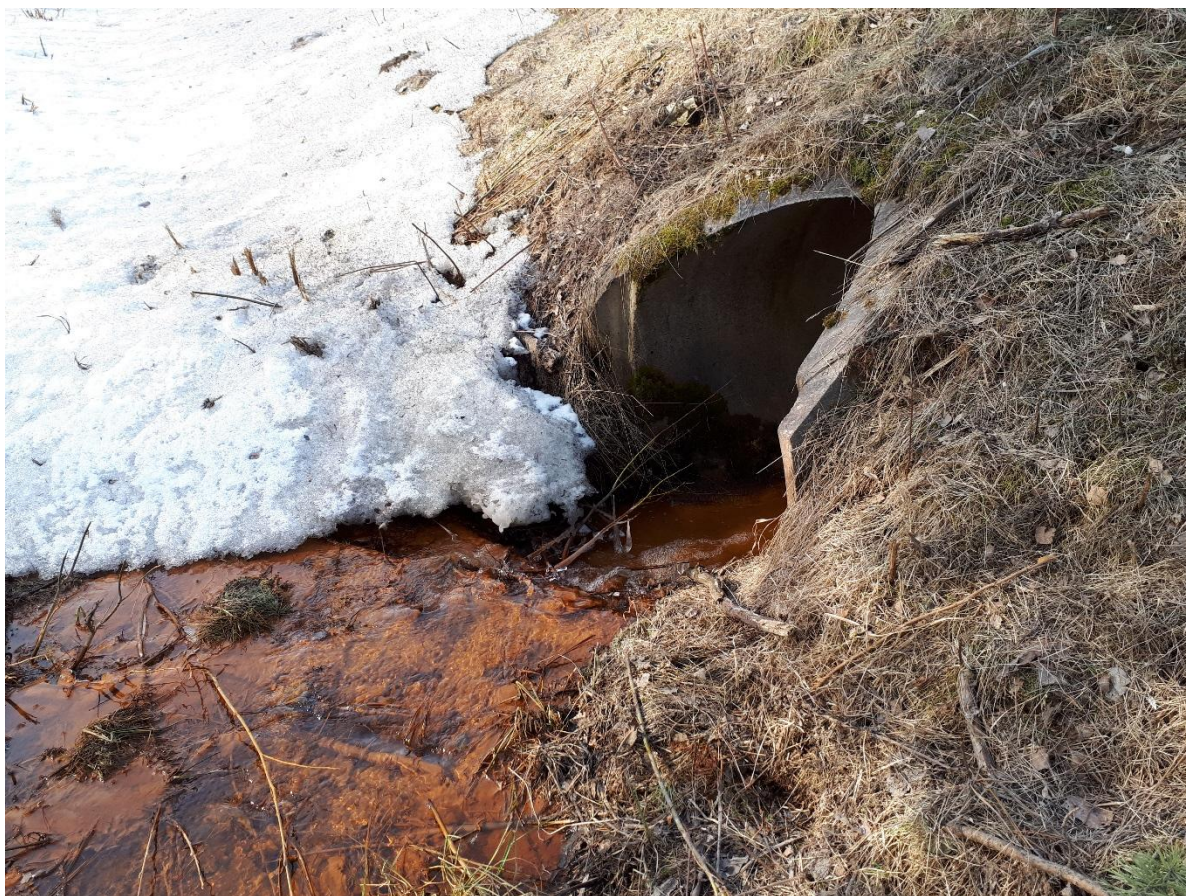
Kuva 2-6. Valtatien alittava rumpu Sukurantien pohjoispuolella
