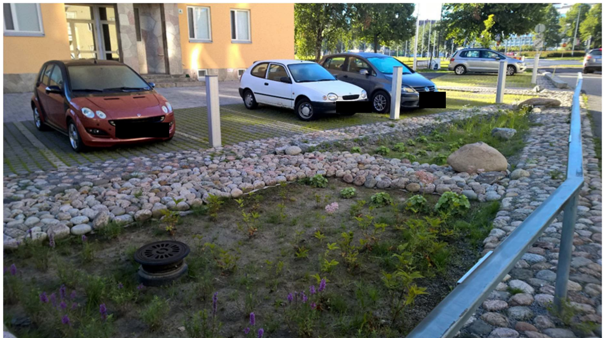
Kuva 3-3. Läpäisevä päällyste ja biosuodatus parkkipaikalla
