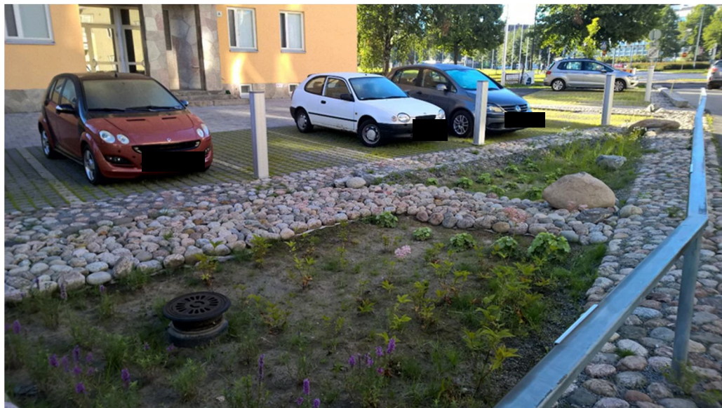
Kuva 3-3. Läpäisevä päällyste ja biosuodatus parkkipaikalla.
