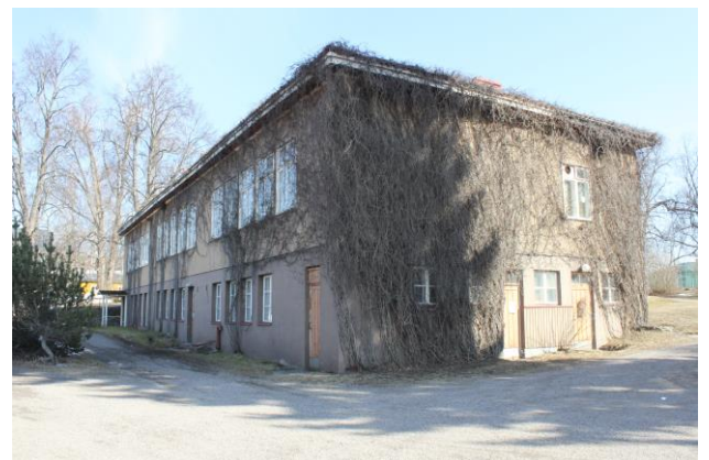
Kuivahoitolarakennus valmistuttuaan ja vuonna 2023.
