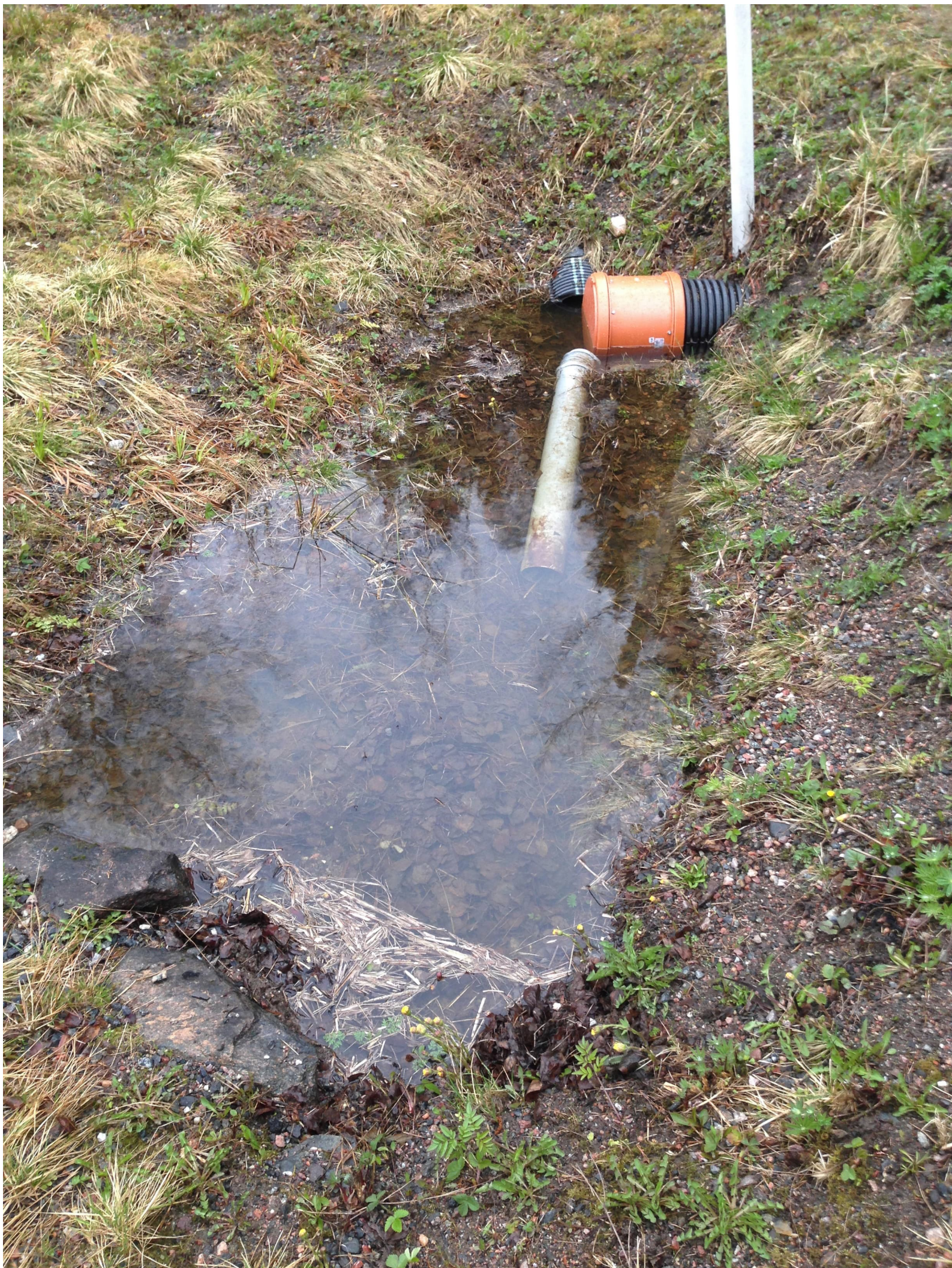
Kuva 13. Kuva rumpuputkesta joka johdettu Itäpirtintie alla tuomaan veden tornille. Kevät 2023.
