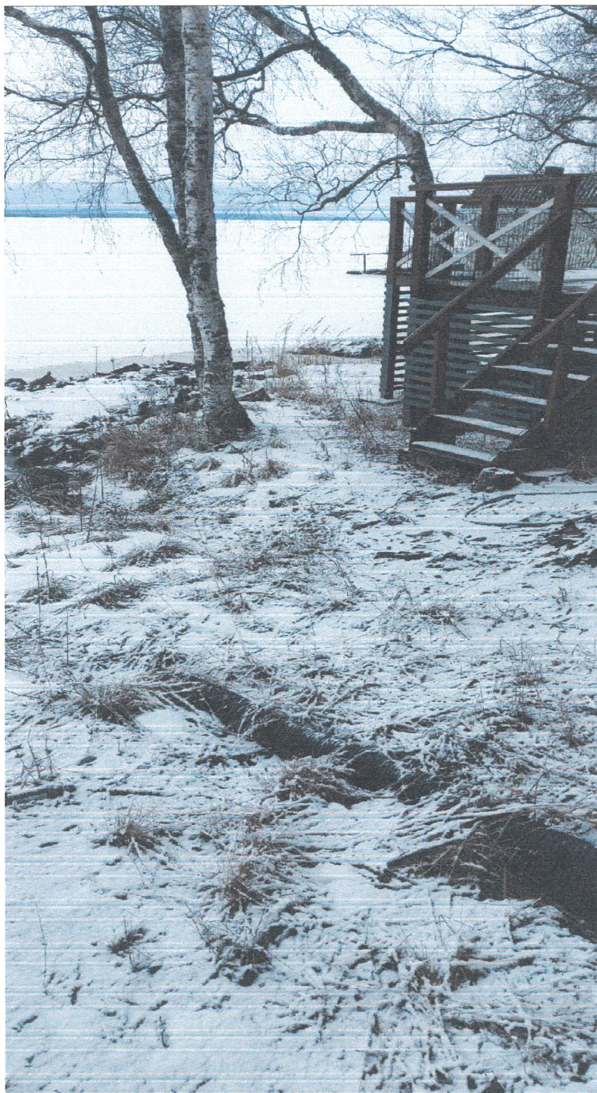
Kuva 6. ... Ø 100 mm muoviputken loppupää sijaitsee saunan portaikon edessä. Putken poisto piha-alueelta kesällä 2023 suoritettavan ranta-alueen rakennustöiden yhteydessä.
