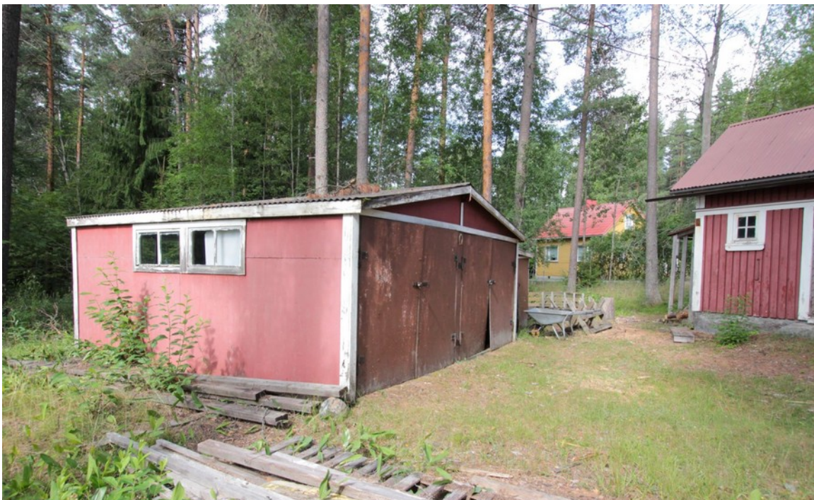
Kuva 4.3.5. Viereinen autotalli (nro 9) puolestaan arvioitiin ulkoa luokkaan 'heikko'.
