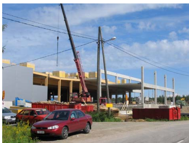
Vuohkallion rakenteilla oleva alue moottoritien varressa.
