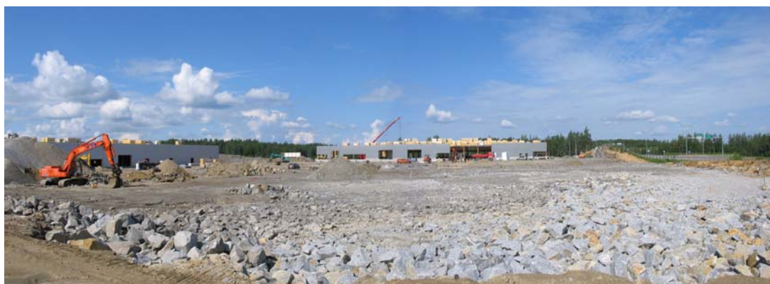
Kuva 3-14. Mittakaavallisesti suuri, rakenteilla oleva kaupan suuryksikkö moottoritien pohjoisen liittymän viereen.
