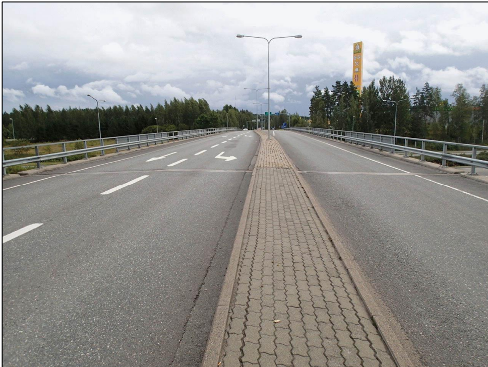
Kuva 14. Mt 412, Sukuran risteyssilta.
