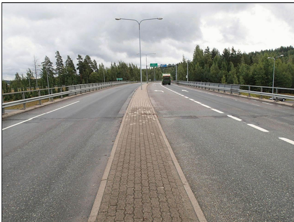
Kuva 13. Mt 411, Pyssyharjun risteyssilta.
