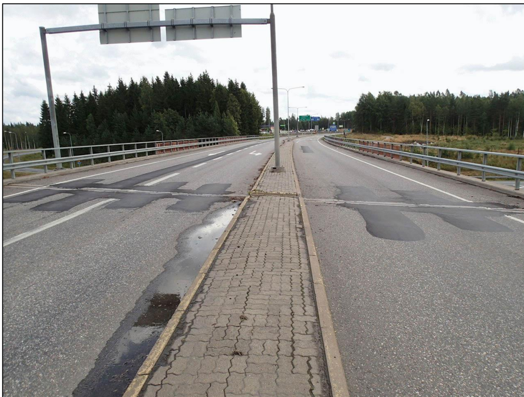
Kuva 10. Mt313, Väaksyntie ja Vierumäen risteyssilta.
