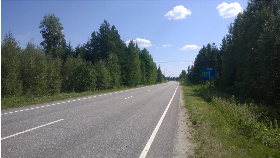
Kuva 12. Maantie 313 Vääksyntie Heikkimäen kohdalla.
