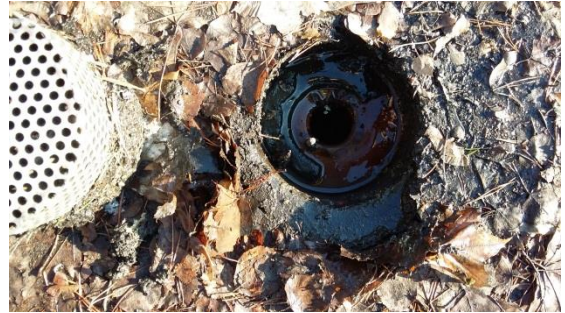
Kuva 2 Putken halkaisija katon pieni pinta-alaan nähden liian pieni
