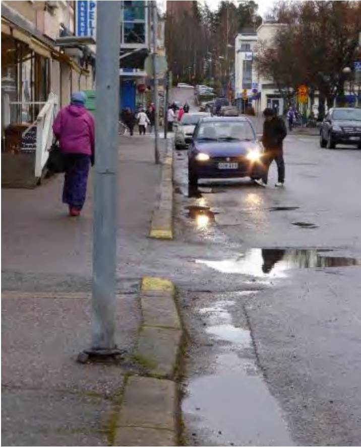
Kuva 1/16, Kirkkokadun peruskorjattava osuus
