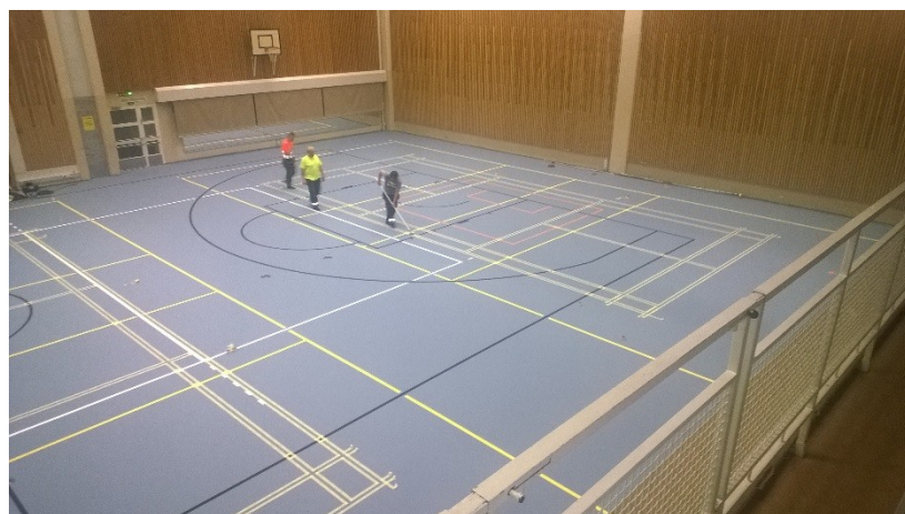
Liikuntahallin lattia saatiin viimeinen uusittua.
