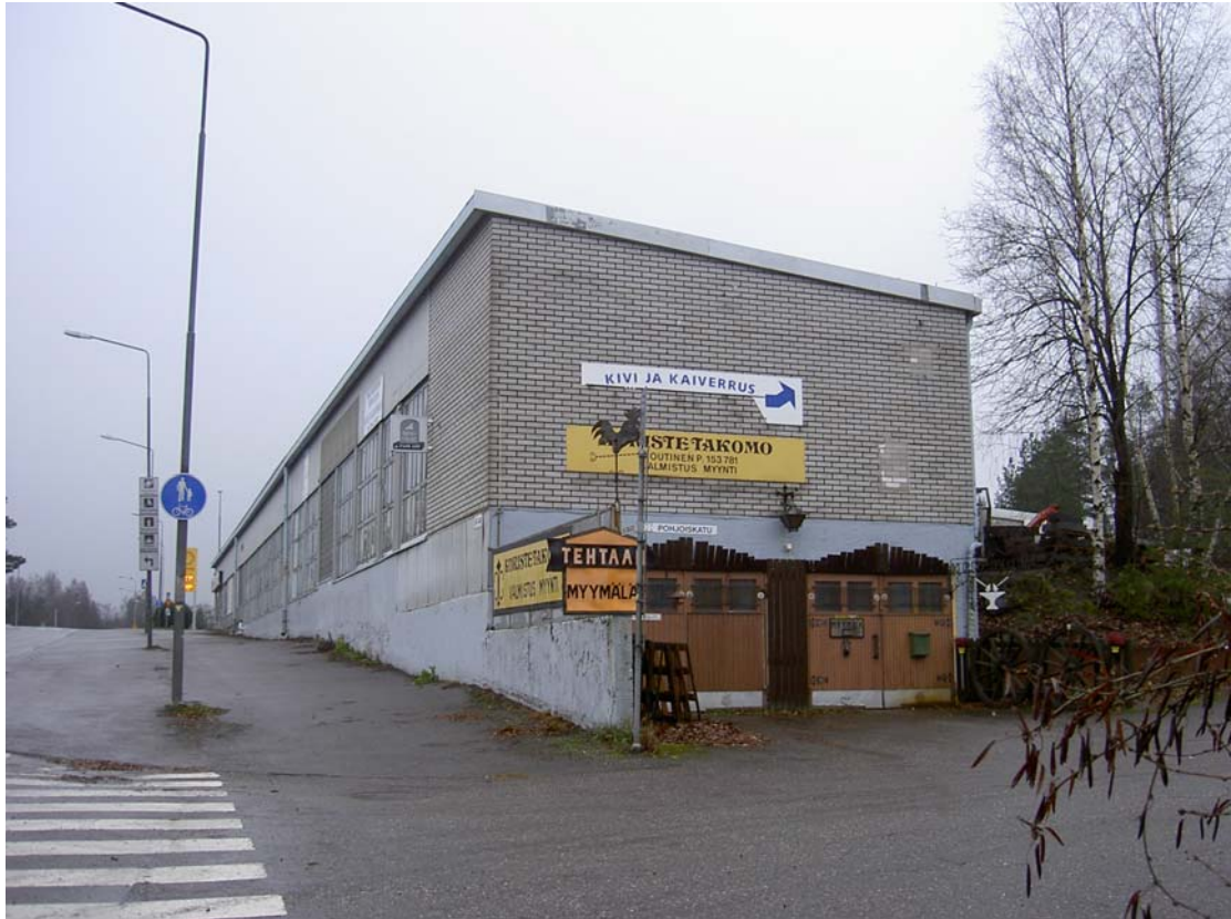
Nykyinen näkymä Siltakadulta. Rakennuksen pohjoispääty.
